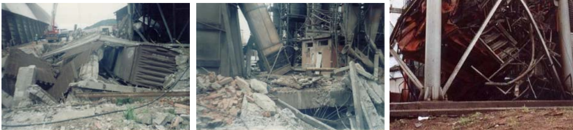
Explosões recentes causadas por poeiras de cereais, neste caso os danos provocados foram aos pavilhões, aos equipamentos de beneficiamento e aos elementos transportadores, o que evidencia que a explosão iniciou dentro internamente, ganhando propagação e aumentando seus efeitos até atingir os pavilhões que foram os finais.
